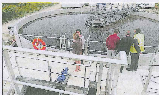
Une autre visite des élus sera programmée en octobre après la construction des bassins d'infiltration et les travaux de voirie et de finition autour de la station.
