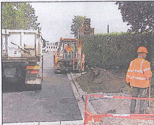
L'entreprise Colas réaménage totalement l'avenue Jean-Moulin, l'une des portes d'entrée vers la mairie et le centre-ville.
