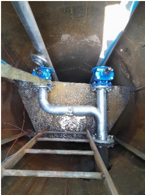
Renouvellement canalisations exhaures et vannes
