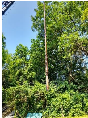
Renouvellement pompe de forage
