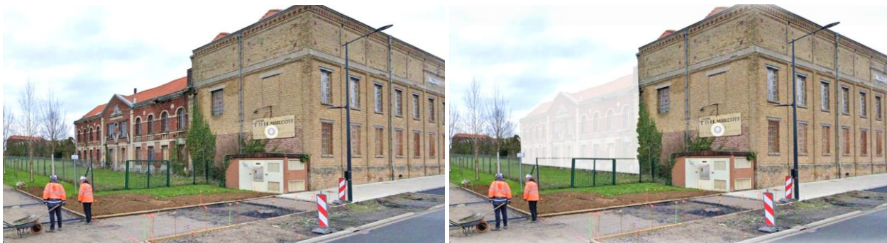
Photographie de la localisation du bâtiment à démolir (Source : Google Streetmap)
