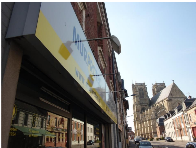
Caissons lumineux ancienne génération avec éclairage en saillie
